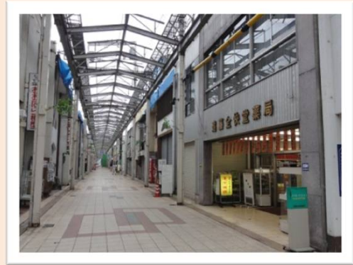
アーケード撤去工事
